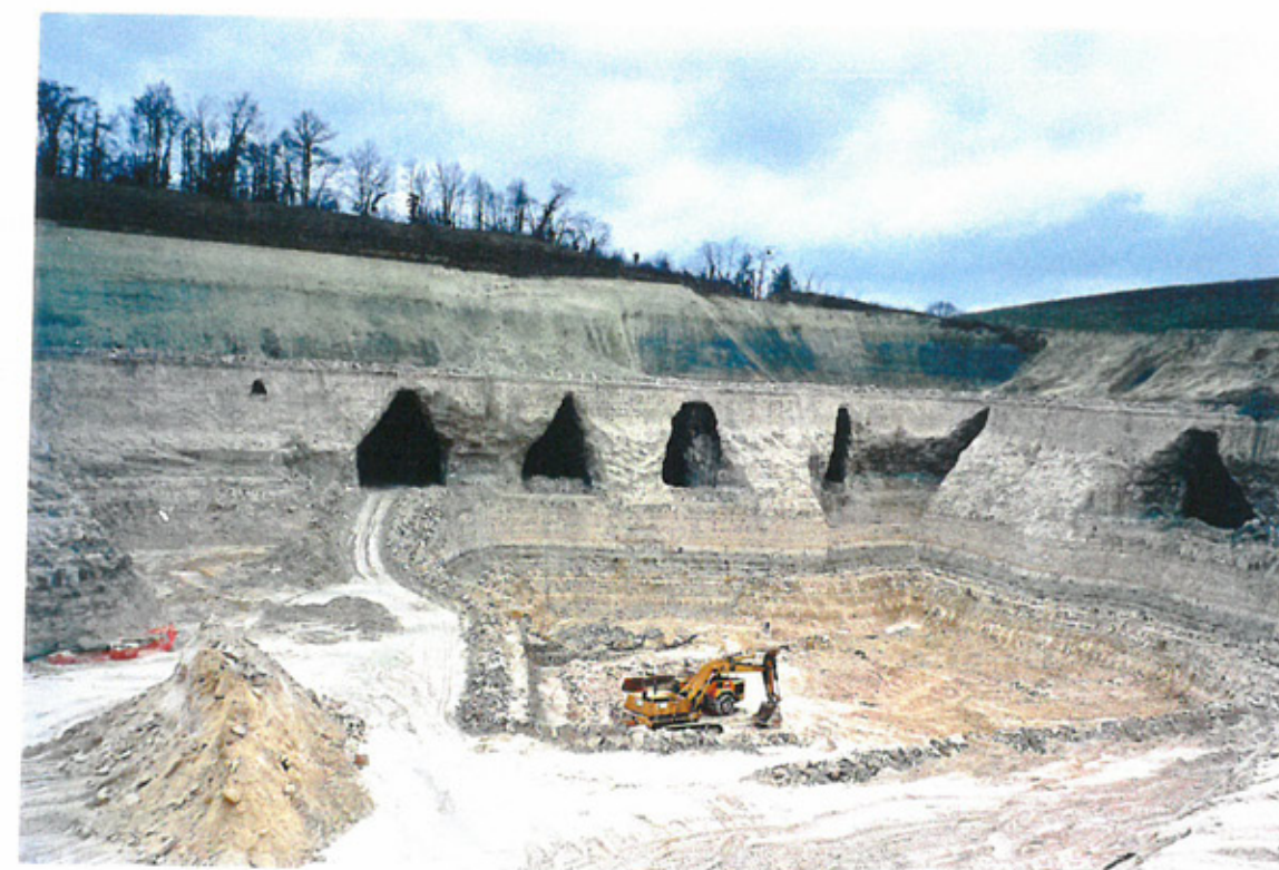
PHOTO 6 : Site de Montzaigle Vue générale – Ruptures locales dans les Marnes de Pantin au-dessus des entrées en cavage
