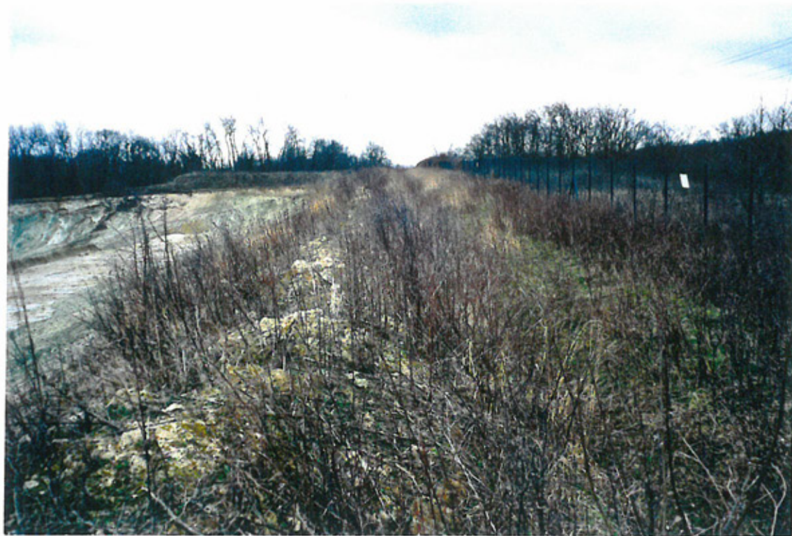
PHOTO 2 : Site de Montzaigle Crête de l'exploitation – Merlon et fossé de tête
