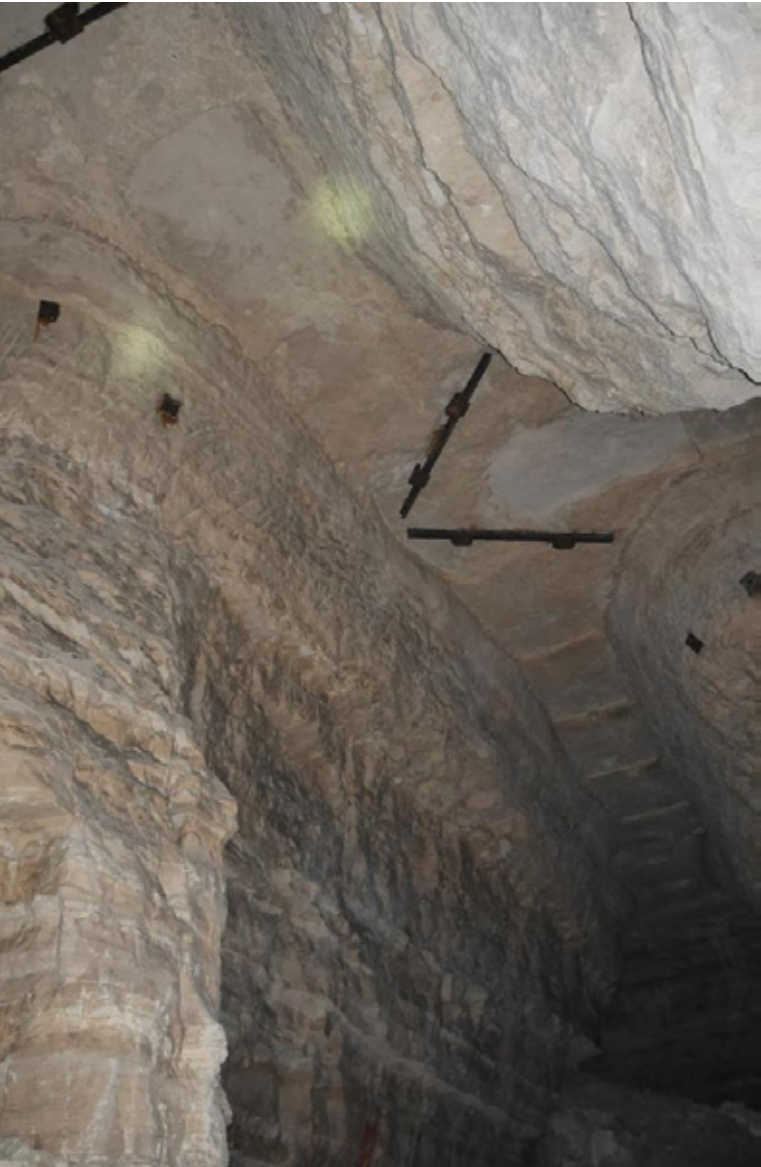
Figure 5 : Toits de la carrière entre les repères F et H
