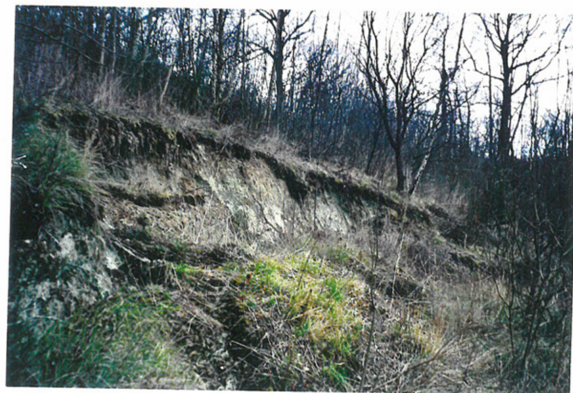
PHOTO 8 : Site d'Aiguisy Rupture localisée dans les Glaises Vertes
