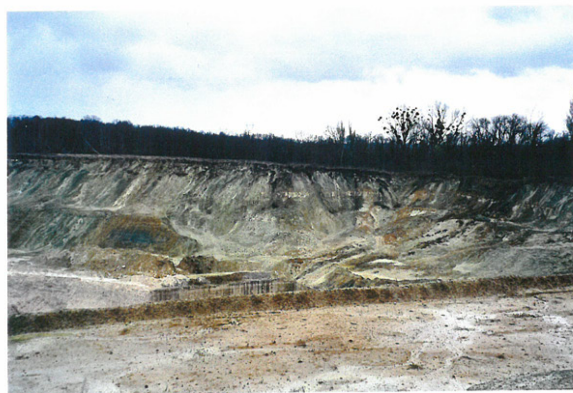
PHOTO 3 : Site de Montzaigle Plateforme de Marnes de Pantin – Coulées d'Argiles Vertes Présence d'eau à noter
