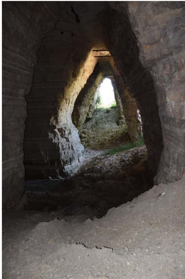
Illustration 9 : Ancienne galerie de la carrière souterraine de gypse
