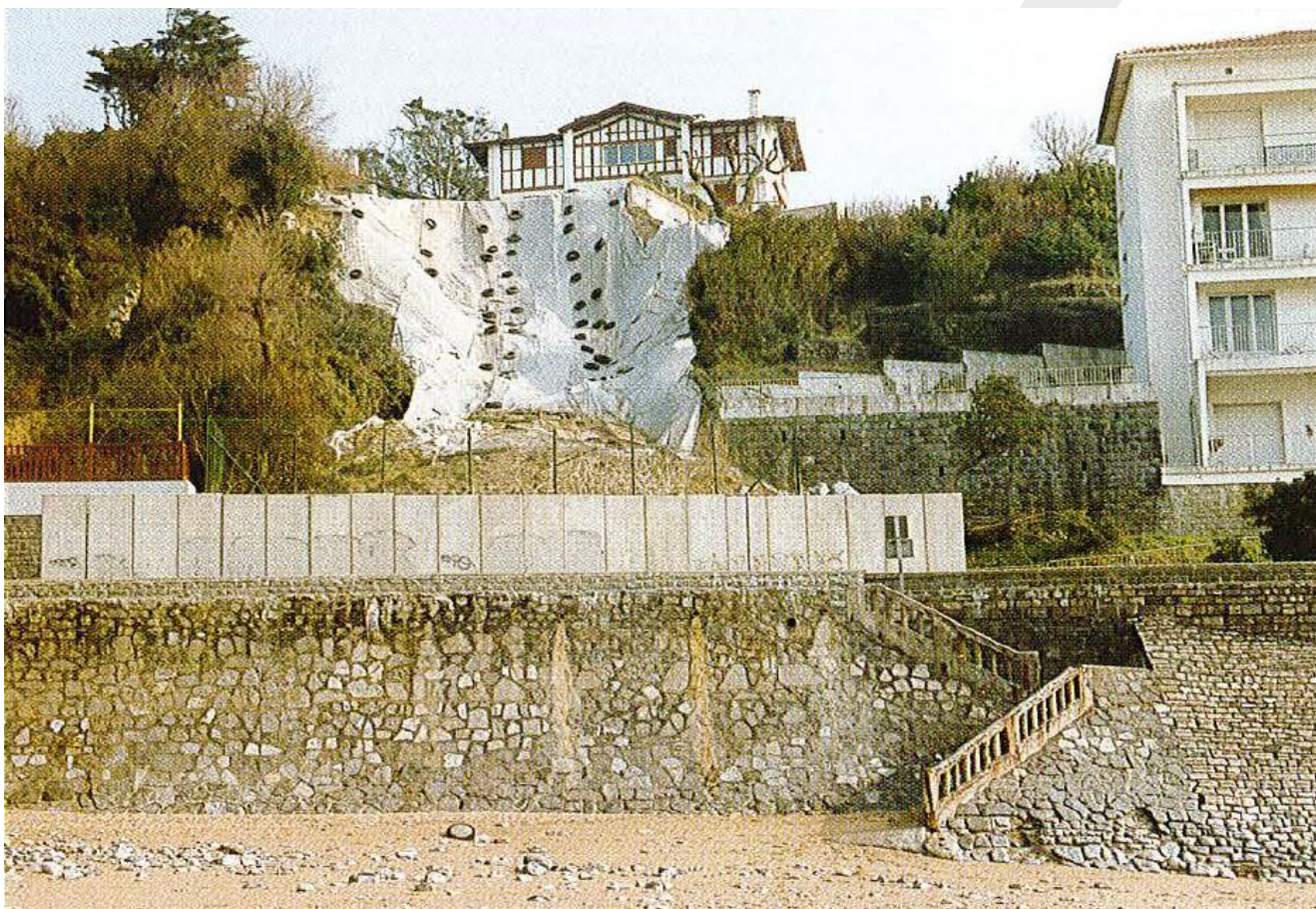
Exemple de bâchage d'une zone glissée
