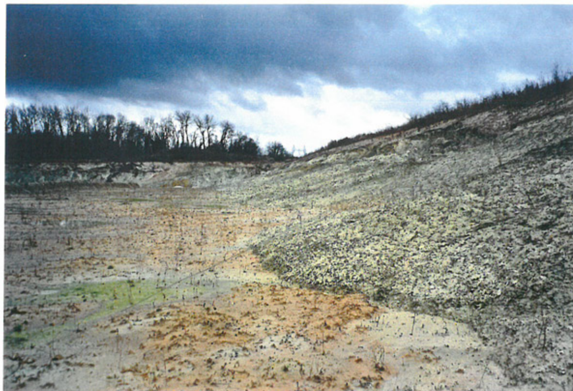
PHOTO 3 : Site de Montzaigle Plateforme de Marnes de Pantin – Coulées d'Argiles Vertes Présence d'eau à noter
