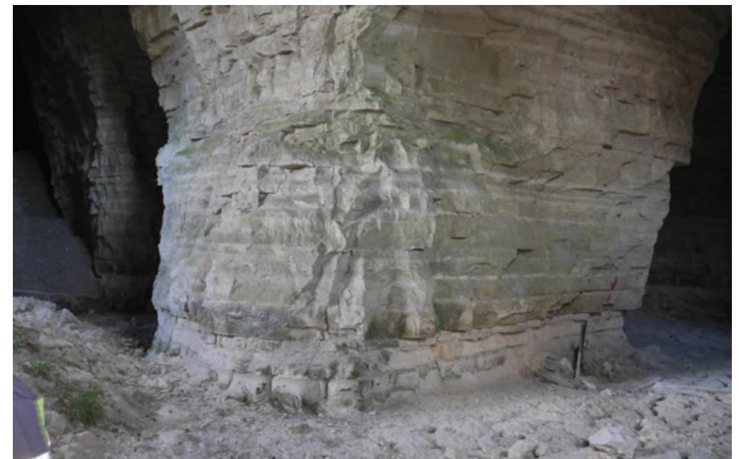
Figure 4 : Base d'un pilier de la première allée, soumis aux altérations climatiques
