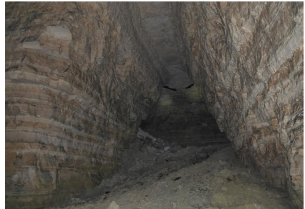
Figure 3 : Vue des piliers et du toit des vieux cavages Ouest au niveau de l'allée K
