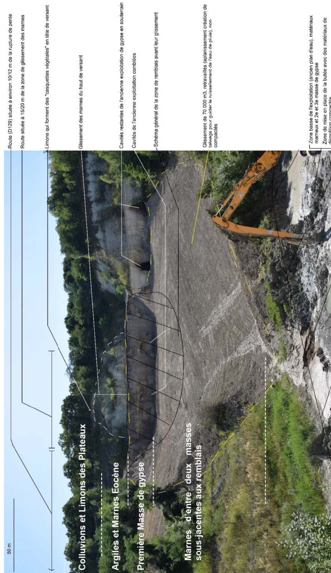
Illustration 15 : Photographie annotée des deux zones de glissement dans la fosse d'Aiguisy
