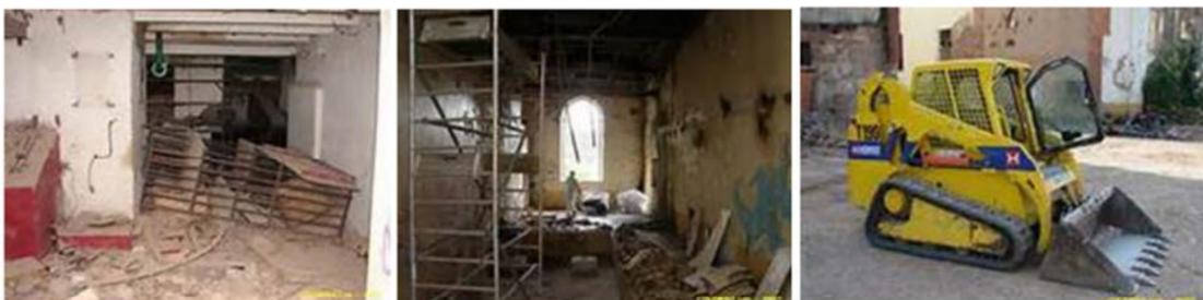
Quand les conditions le permettront, ce curage pourra se faire au moyen d'une mini pelle. Certains éléments nécessiteront une découpe au chalumeau ou à la disqueuse.
