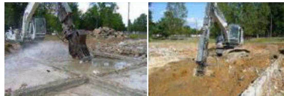
Conformément aux servitudes, un lavage à grande eau sera pratiqué, durant la démolition, sur les réseaux ayant pu être impactés par une pollution pyrochimique. Les boues seront récupérées puis contrôlées (cf. 8.3.1.5 Le contrôle des boues).
