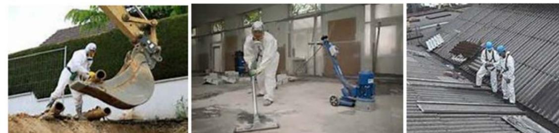
Les travaux de désamiantage seront réalisés selon la réglementation en vigueur. Le port d'équipements de protection respiratoire adaptés (masque de type FFP3 à minima) est requis pour ces travaux.
