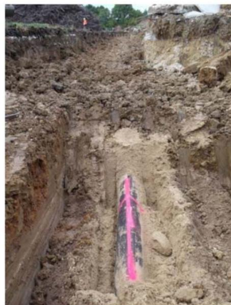
Conformément aux servitudes d'utilité publique, les opérations d'excavation des canalisations seront réalisées à l'aide d'engins de chantier permettant au conducteur d'être relativement éloigné (au minimum de 2 à 3 mètres). Les excavations seront ainsi réalisées à l'aide d'une pelle mécanique, par couches successives de 50 cm jusqu'à atteinte de la canalisation afin de vérifier la présence éventuelle de munitions dans les terres.
