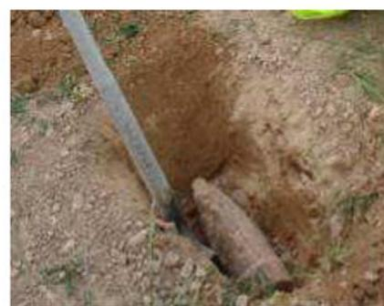
Pendant le déterrage, la localisation précise des cibles est réalisée à l'aide d'une sonde magnétométrique.
