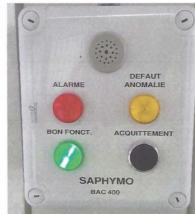
**Figure 2 : Boîtier de fonctionnement dans le poste de contrôle**
