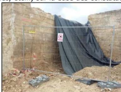
Figure 2 : Exemple de sécurisation de zone dans laquelle ont été trouvés des objets contaminés
