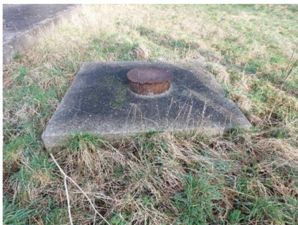
Il existe également 2 piézomètres (BSS000JHBK, BSS000JHBL) entre les forages F1 et F2 dans la parcelle AC 372. Ils présentent un état dégradé : les dalles de propreté sont friables et les têtes acier sont très oxydées, descellées et un capot n'est plus en place.
