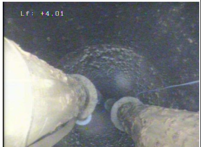
A 4.27 m, des nodules de corrosion sont visibles sur la paroi acier.
