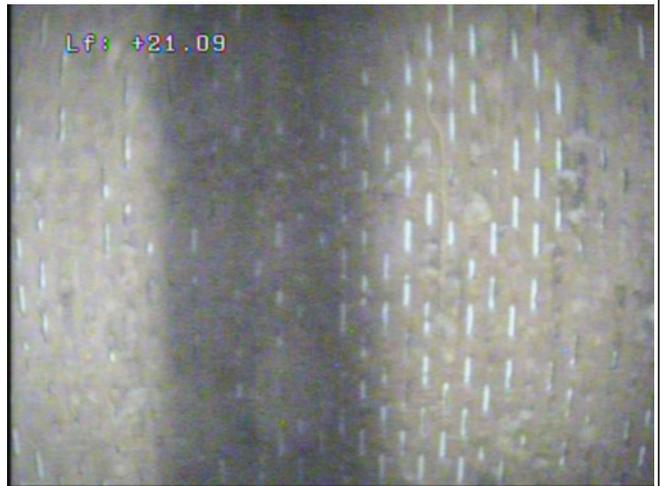
En base du tubage acier crépiné observé, les concrétions semblent plus importantes sur la paroi.
