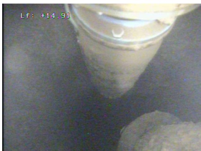
Les deux colonnes d'exhaure prennent fin aux cotes 15.13 et 15.97 m/repère, avec un raccord à double brides en acier, reliant chacune des colonnes à une pompe d'exploitation. On note que la boulonnerie de la bride acier à 15.97 m, semble présenter une légère corrosion.
