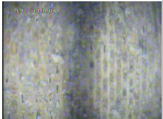
A 21.65 et 22.52 m, on observe sur la paroi du tubage acier crépiné, en plus des nombreuses concrétions, des filaments bactériens.
