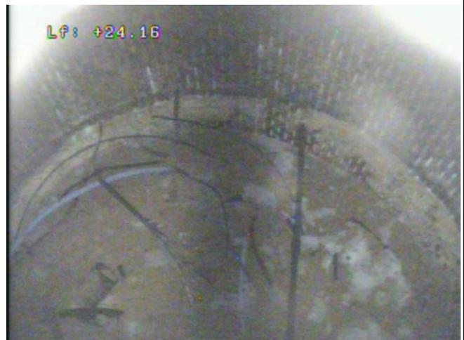
En base d'ouvrage, les crépines semblent colmatées en grande majorité (supérieur à 80 %) par du dépôt et des concrétions ferreuses et calciques.
