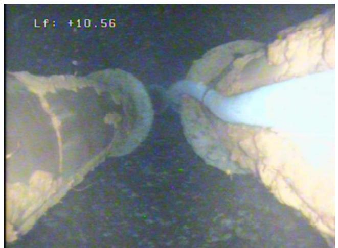
Les deux colonnes d'exhaure prennent fin aux cotes 14.42 et 14.85 m/repère, avec un raccord à double brides en acier, reliant chacune des colonnes à une pompe d'exploitation. Le dépôt empêche de contrôler l'état de la boulonnerie.
