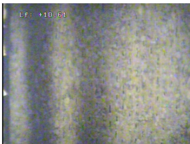
Au-delà de 12 m, le colmatage des crépines semble de plus en plus important (environ 70% vers 14m). Pour les fentes encore « ouvertes », on distingue la masse de Craie à l'extrados du tubage.
