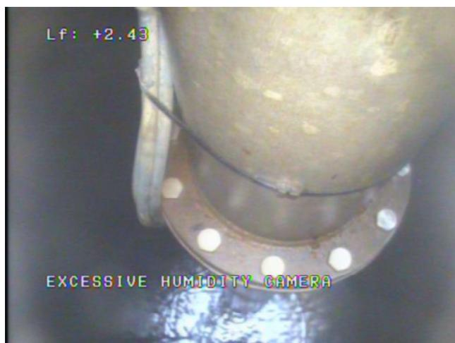
Sous le niveau statique, on observe quelques dépôts et concrétions au sommet des brides acier des deux colonnes d'exhaure, ainsi que sur les colonnes acier elles-mêmes. La boulonnerie apparaît dans l'ensemble en bon état.
