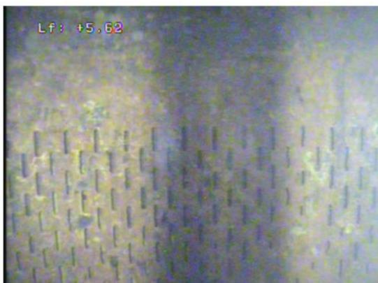
Tubage acier crépiné à fentes verticales (Ø 1000 mm) en bon état / Fentes ouvertes / légère corrosion de la paroi
