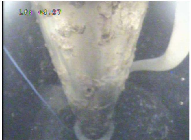
Sous le niveau statique, on observe quelques dépôts et des concrétions au sommet des brides acier ainsi que sur les deux colonnes d'exhaure.
