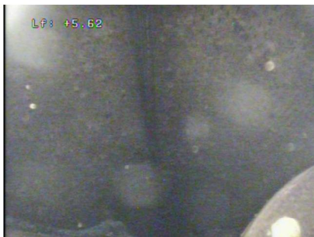
Dès 7 m, la paroi du tubage acier crépiné apparaît en partie tapissée de dépôts ferro-bactériens colmatant environ 50% des fentes de crépine. Aucun massif filtrant n'est observé à l'extrados du tubage crépiné.
