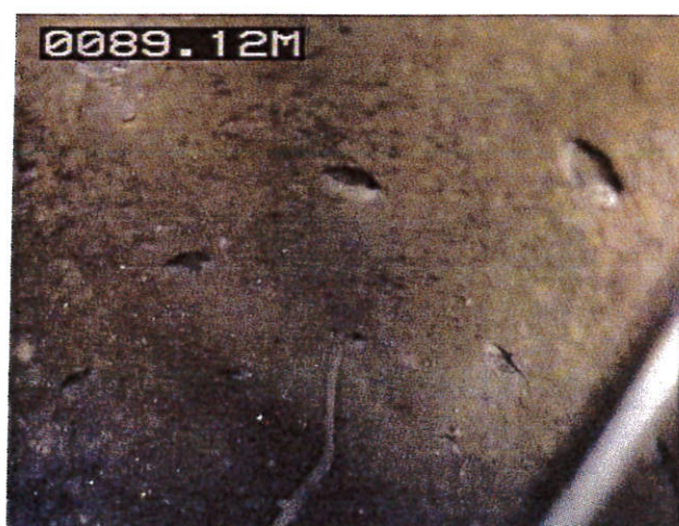
Vue des perforations avec nombreux serre-câbles pris entre le tube plein et le tube crépiné
