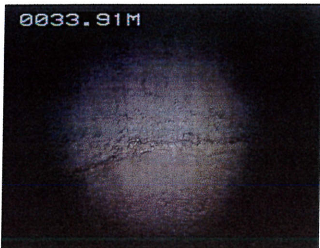
0033.91M Paroi maçonnée du cuvelage au niveau d’une zone de jonction (absence de suintements)
