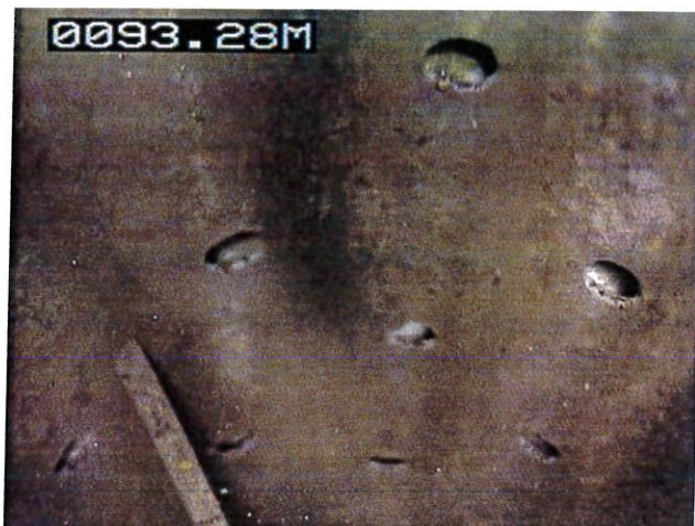
Crépines bien ouvertes, absence de massif filtrant
