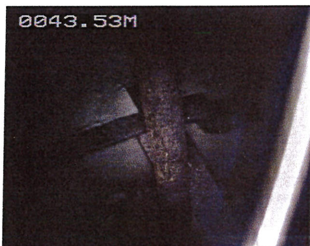
0043.53M Ancien tronçon de colonne d’exhaure posée contre dans l’armature d’un plancher intermédiaire
