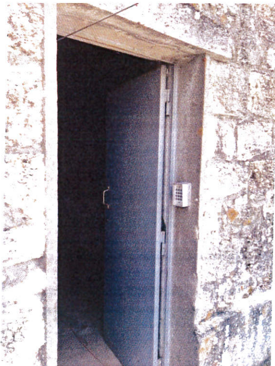
Figure 18 : Alarme de protection avec contacteur de porte
