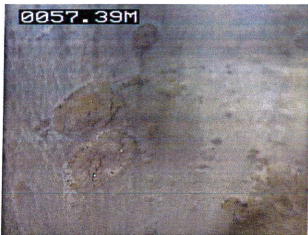
Jonction des tubes par rivets
