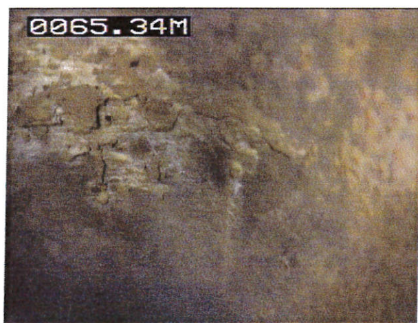
Cicatrices d’arrachement de concrétions. Les concrétions sont mêlées d’oxydes de fer dès 61 m
