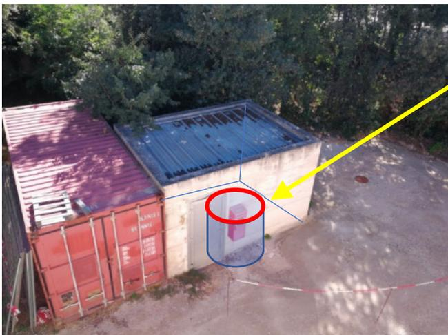
Le puits (représenté en 3D sur la photo ci-contre) se trouve à l'intérieur d'un bâtiment maçonné, disposant d'une toiture étanche et fermée par une porte métallique.
