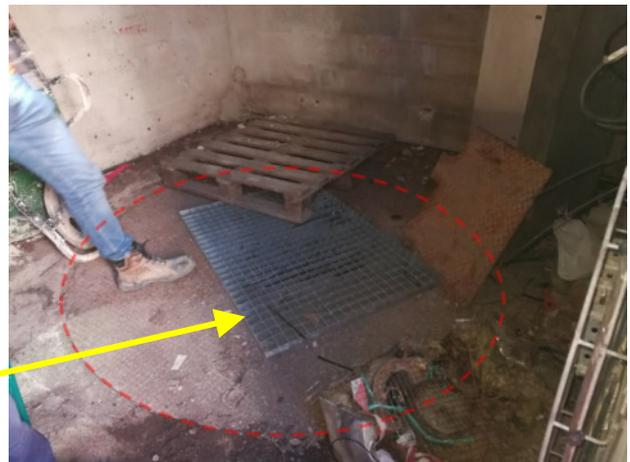
A l'intérieur du bâtiment, le puits est fermé par une plaque métallique disposant d'une ouverture en son centre pour l'équipement de pompage.
