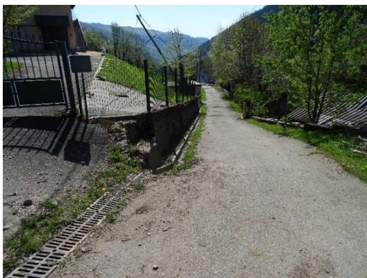
Caniveau de collecte des eaux de ruissellement
