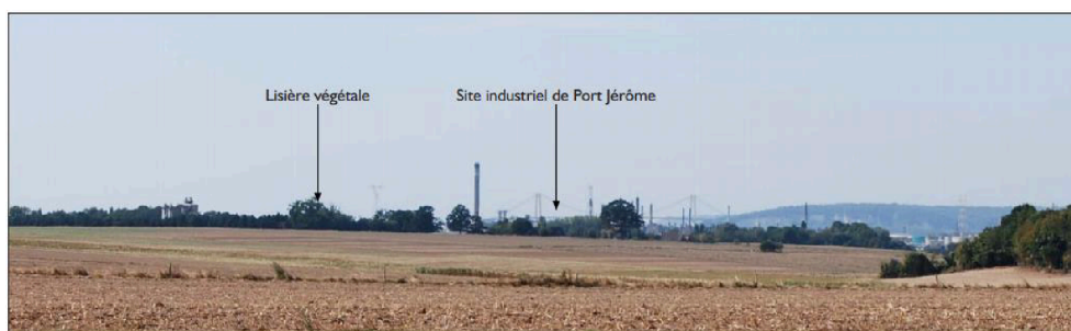
Figure 16 : La lisière végétale en bordure du site industriel diminue considérablement l'impact des équipements
