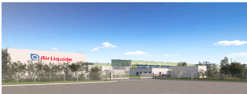
Figure 35 : Vue entrée Nord du site
