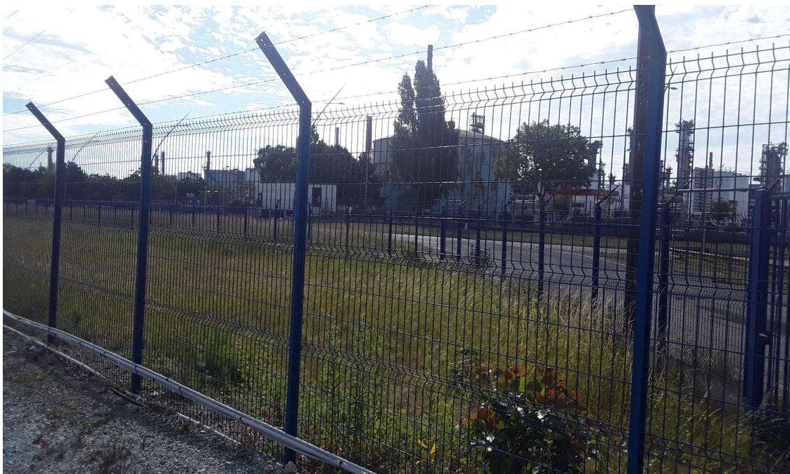
Exemple de maillage rectangulaire de 150 mm x 50 mm
