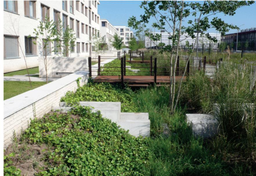
Système de bief. Noue non infiltrante, ruissellement et tamponnement jusqu'au réseaux publics.
