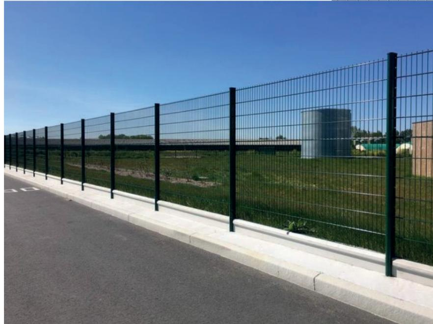
La clôture périphérique du site sera composée de panneaux rigides d'une hauteur de 2 mètres, incluant un soubassement en béton. Elle assurera ainsi la sécurité du site tout en restant discrète grâce à sa teinte (RAL 7030 ou 7035), qui s'harmonise parfaitement avec l'environnement et l'architecture des bâtiments adjacents.
