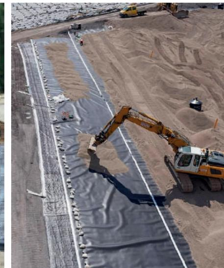
Un géotextile bentonitique est un matériau composite constitué de couches de géotextile encapsulant de la bentonite, utilisé pour l'étanchéité dans les travaux de génie civil, comme les décharges ou les bassins. La bentonite forme une barrière imperméable.
