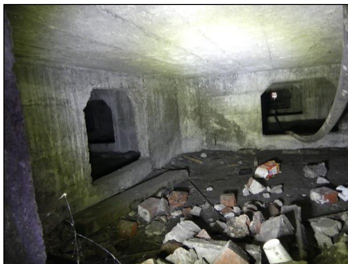
Photographie 15 : Cave au sein d'un bâti, faiblement potentiel à l'accueil des chiroptères du fait d'une trop grande ouverture donnant sur l'extérieur
