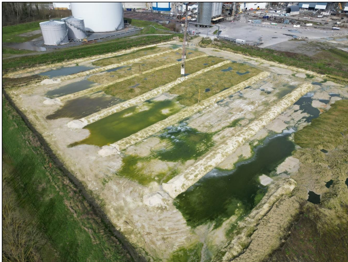
Photographie 3 : Bassin d'écume
