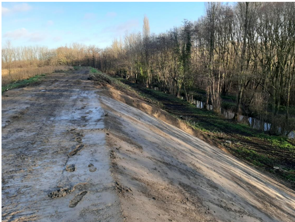
Figure 22 : Bassin 10, Digue Est, décapage de 20 cm en cours – Janvier 2021
