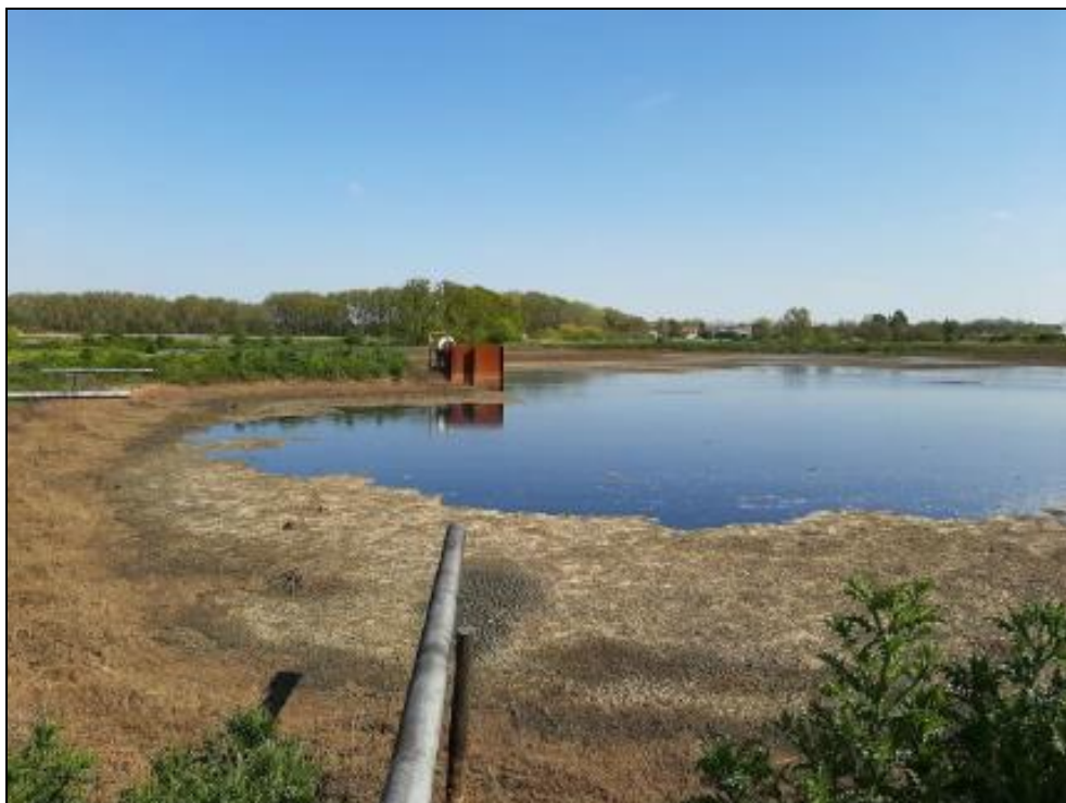
Figure 7 : Vue générale du bassin depuis l'angle Nord-Ouest
