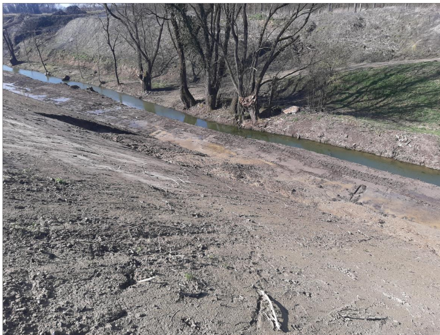
Figure 25 : Glissement du parement suite au décapage – comblement en masque granulaire
