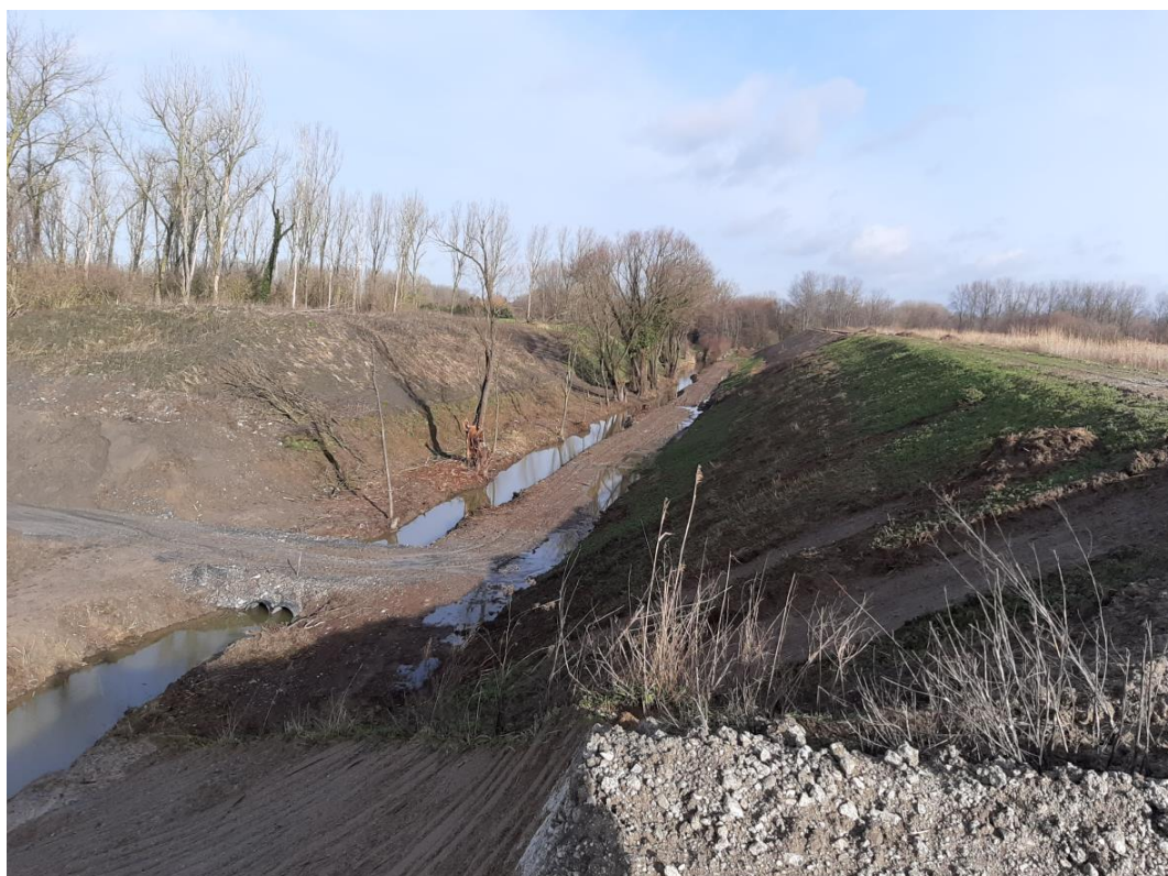
Figure 21 : Bassin 10, digue Ouest, pied de digue à rehausser - Janvier 2021
