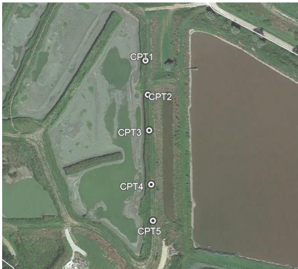
Figure 3 : Position des CPT au droit de la digue Est du bassin Recyclage
