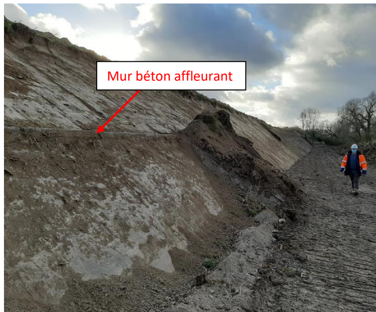
Figure 9 : Bassin La Hutte 1, digue Ouest (17/12/2020)
