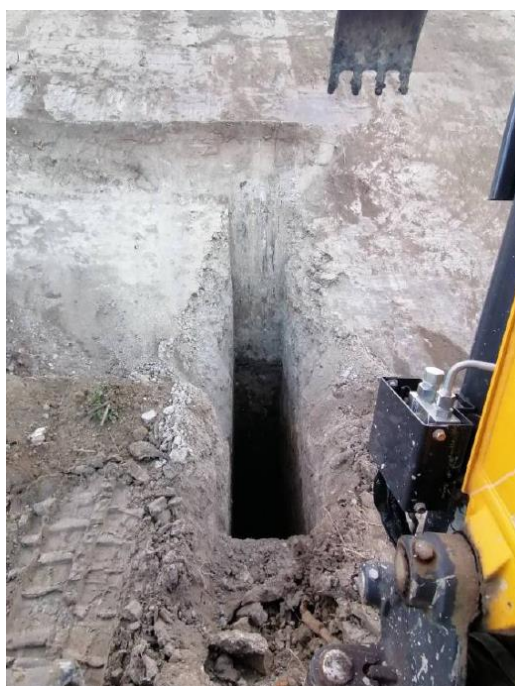
Figure 10 : Bassin La Hutte 1, digue Ouest, sondage
