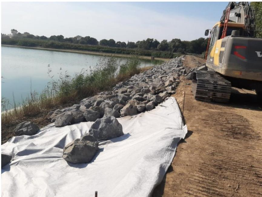
Photo 8 : Travaux d'engrochement sur le parement interne du remblai Nord de Regnault – 15/09/2020
