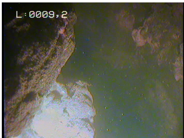
Nodules indurés sur la colonne de pompe et la paroi du forage
