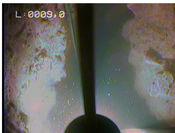
Vue sur la bride de la crépine d'aspiration, nombreux nodules indurés
