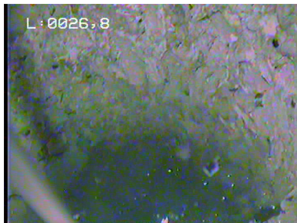
Paroi encroutée, crépine en partie colmatée
