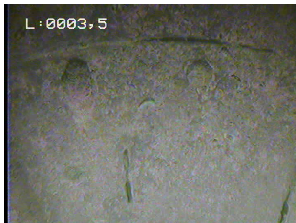
3.5m : joint riveté et début de la crépine à fente verticale
