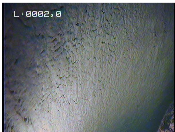
Nappage de la paroi par un fin dépôt
