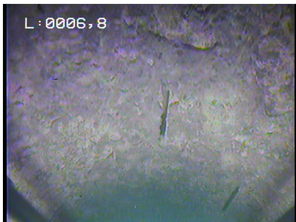
Paroi avec béton et crépines ouvertes
