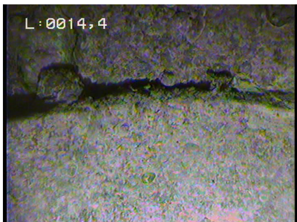
Vue sur la réduction de diamètre
