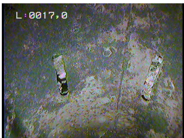
Crépine rectangulaire artisanales bien ouverte, terrain visible sans massif filtrant
