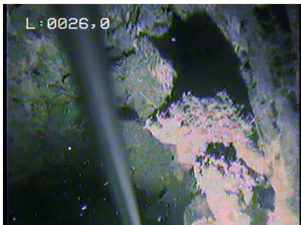
Paroi avec dépôt induré
