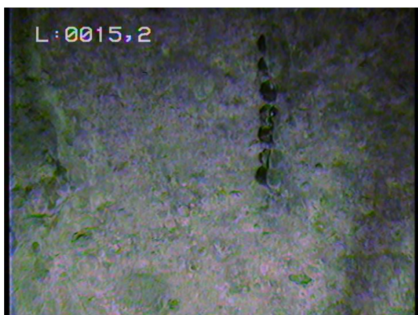
Crépine ouverte (multiple trou vraisemblablement fait à la perceuse ou chalumeau)
