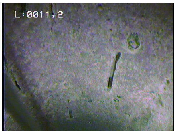
Crépine rectangulaire artisanale bien ouverte, terrain visible sans massif filtrant
