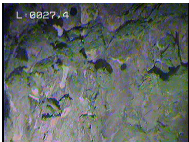
Dépôt induré sur la paroi de la crépine
