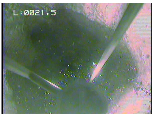
Vue sur le tour nu, craie apparaissant massive, circonférence du forage irrégulière
