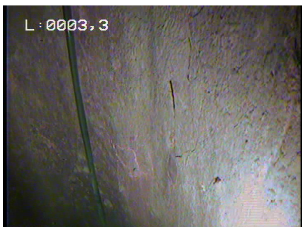
Paroi oxydée/encroutée
