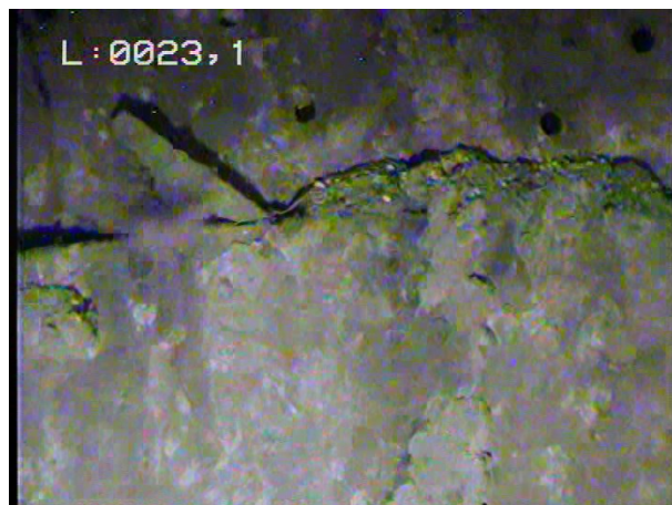
23.1m : réduction de diamètre
