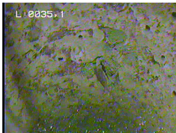
Paroi partiellement colmatée
