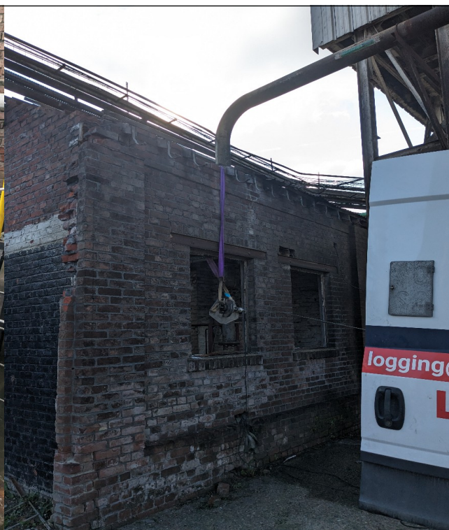
Installation sur le F5
