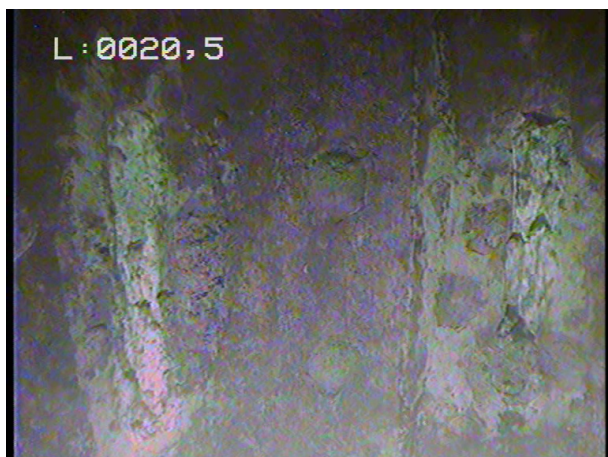
Vue sur deux crépines comblées, espace annulaire rempli (vraisemblablement terrain éboulé)
