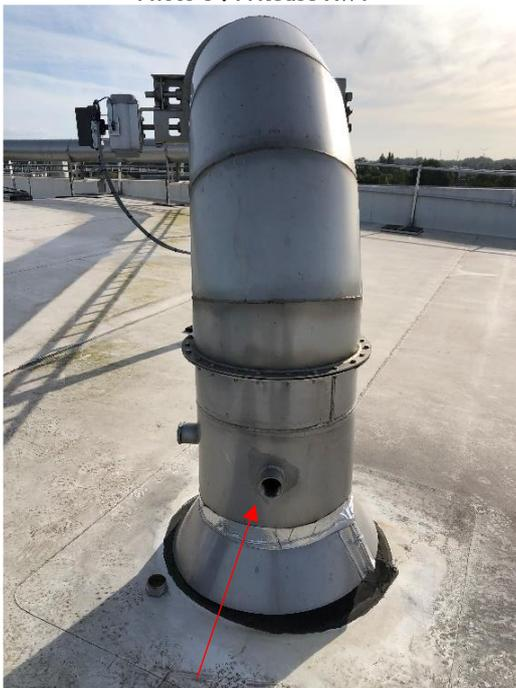
Photo 7 : Sortie condenseur épluceuse AW1
