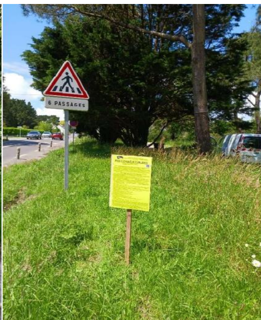
N°2 : carrefour route de Kerroux/RD99
