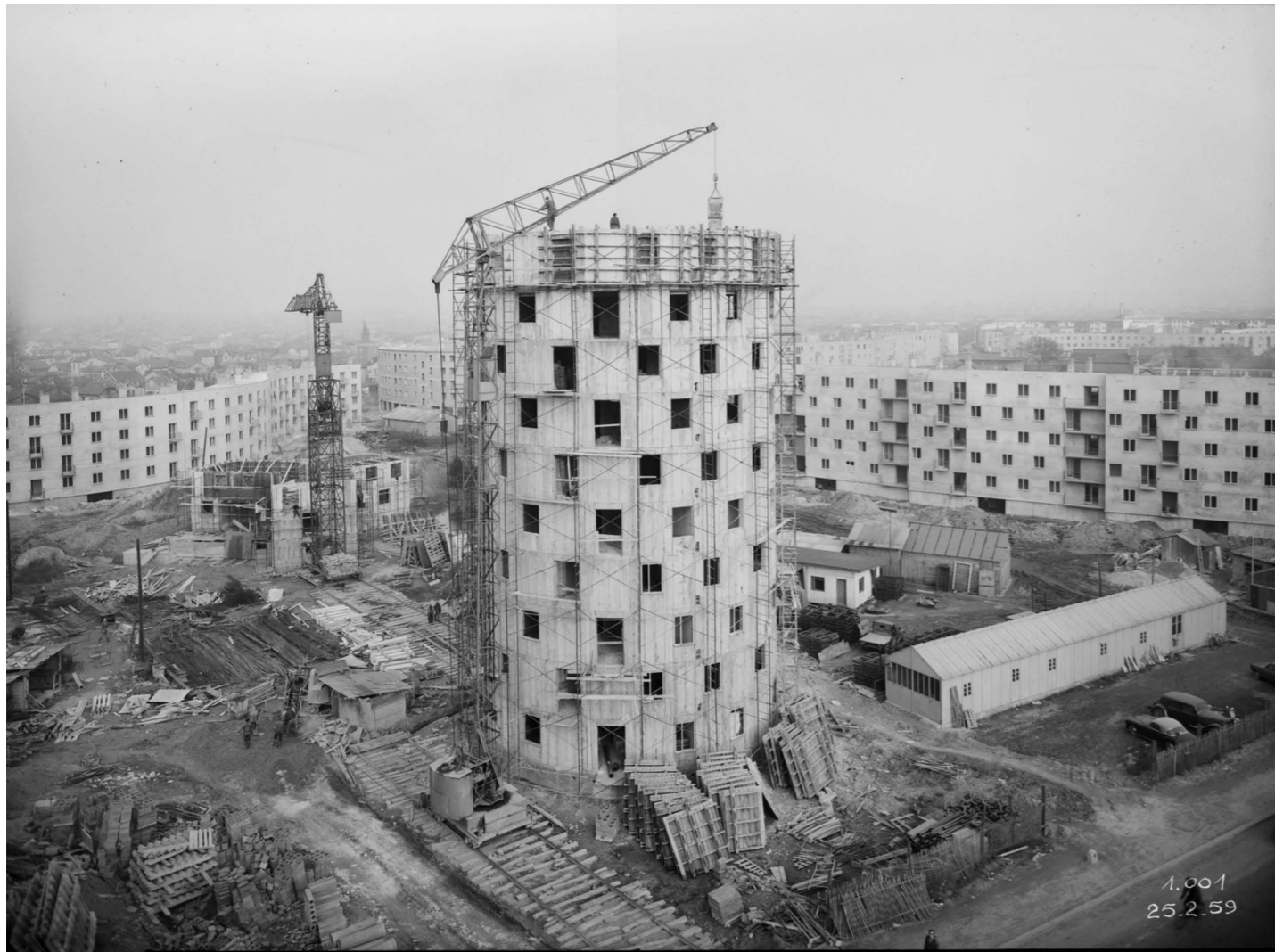
Cité de l'abreuvoir, tour ronde 3 ème tranche en chantier, photographie Henri BARANGER pour OTH, datée du 25 février 1959, AD 93
