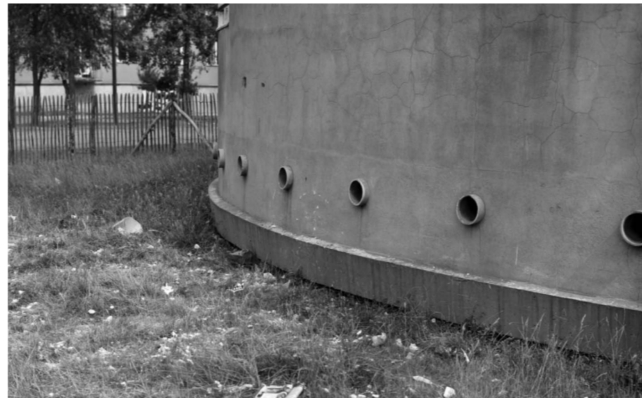
Soudoirs des sous-sol de cave, tour ronde 3 ème tranche, photographie Henri BARANGER pour OTH, datée du 3 juillet 1967, AD 93
