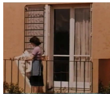
Menuiseries types F5 et PF2, bâtiment étoile, dans le film « Cités du soleil », réalisé par Jean-Claude Sée en 1958, https://www.dailymotion.com/video/xgj74q
