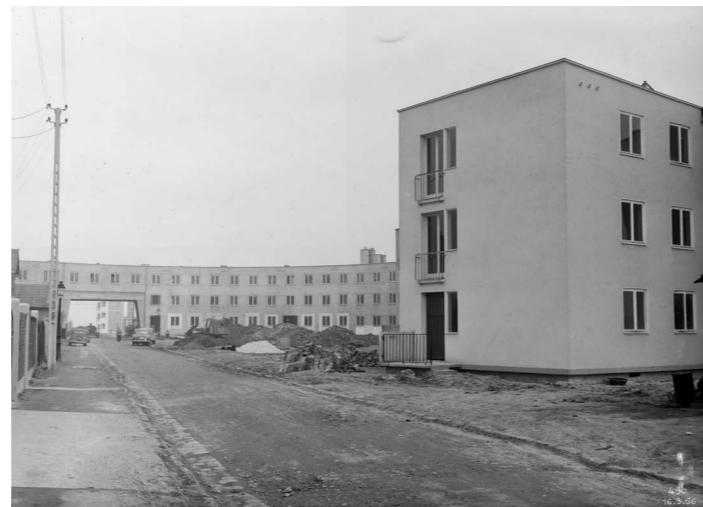
Cité de l'abreuvoir, bâtiments 1 ère tranche en chantier, photographie Henri BARANGER pour OTH, datée du 16 mars 1956, AD 93
