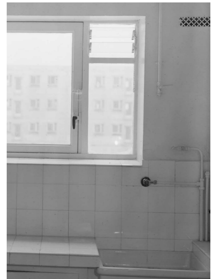
Grilles de protection en métal déployé conduit de salle de bain dans bâtiment Est-Ouest (Védres) et grille en façade d'une cuisine dans un bâtiment Nord-Sud (Védres), 1 ère tranche, photographies Henri BARANGER pour OTH, datées du 16 mars 1956, AD 93
