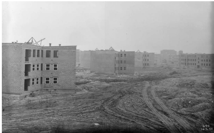
Cité de l'abreuvoir, bâtiments étoilés en chantier, photographie Henri BARANGER pour OTH, datée du 16 mars 1956, AD 93
