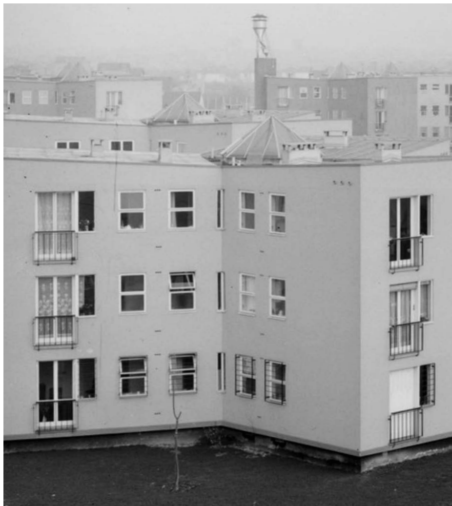
Bouches circulaires d'aération des combles en façade des bâtiments étoilés et souches des conduits en toiture
