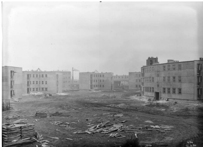
Cité de l'abreuvoir, bâtiments 1 ère tranche en chantier, photographie Henri BARANGER pour OTH, datée du 16 mars 1956, AD 93
