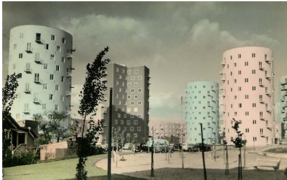
Les baies décalées des tours de la cité de l'Abreuvoir (1952-1964) réalisées selon un procédé TRACOBA, préfigurant la technique du coffrage glissant
