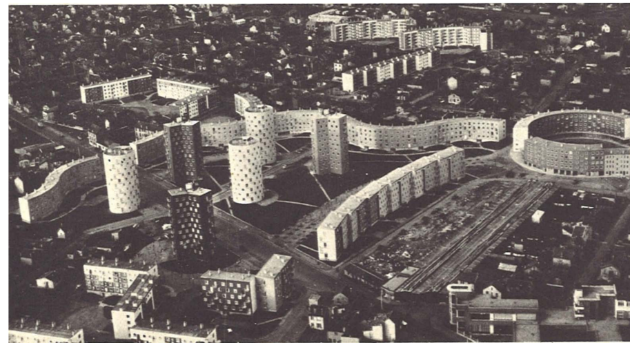
Vue d'avion de la cité publiée dans les revues : Urbanisme en 1960 et L'œil en 1962
