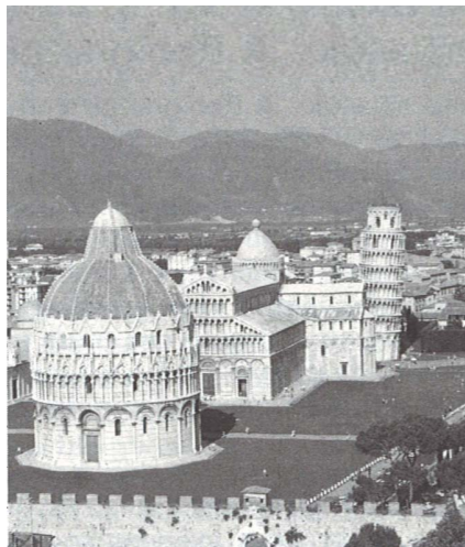
Pise : cathédrale, baptistère, bâtiment et tour placés de guingois
