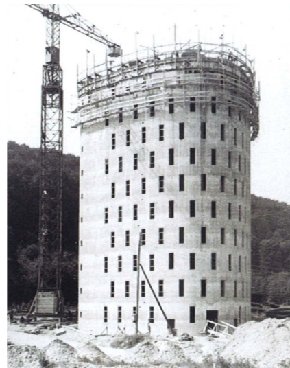
Cité du Wiesberg, tour parabolique mise en oeuvre du coffrage glissant
