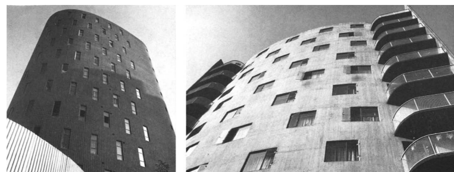
Les baies décalées des tours de la cité du Wiesberg à Forbach (1959-1973), réalisées par coffrage glissant
