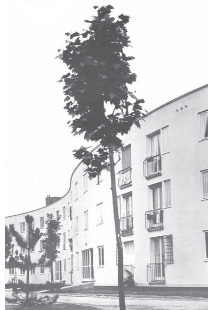
Accès aux bâtiments courbes
