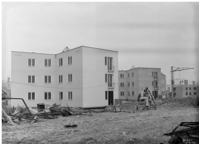
Cité de l'abreuvoir, bâtiments étoilés en chantier, photographie Henri BARANGER pour OTH, datée du 16 mars 1956, AD 93
