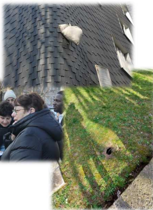
Des galeries creusées par les rongeurs en pied d'immeuble, aussi présents dans les caves .
