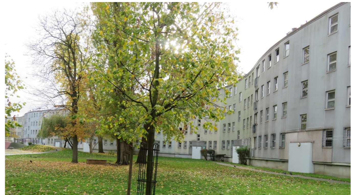
Halls traversants existants (hauts) et condamnés (bas) / Even conseil
