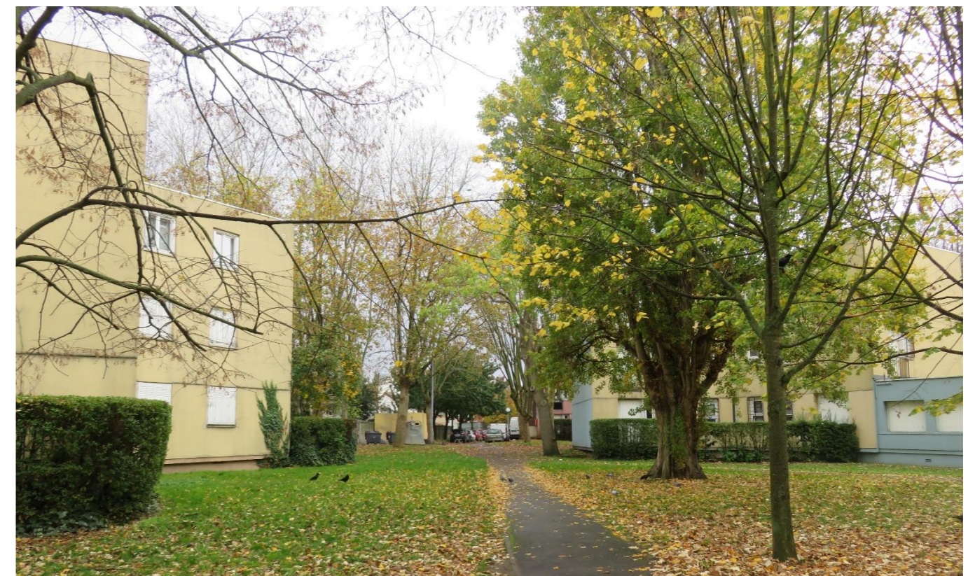
Une faible hauteur du bâti qui rend ces constructions discrètes dans le paysage urbain / Even conseil
