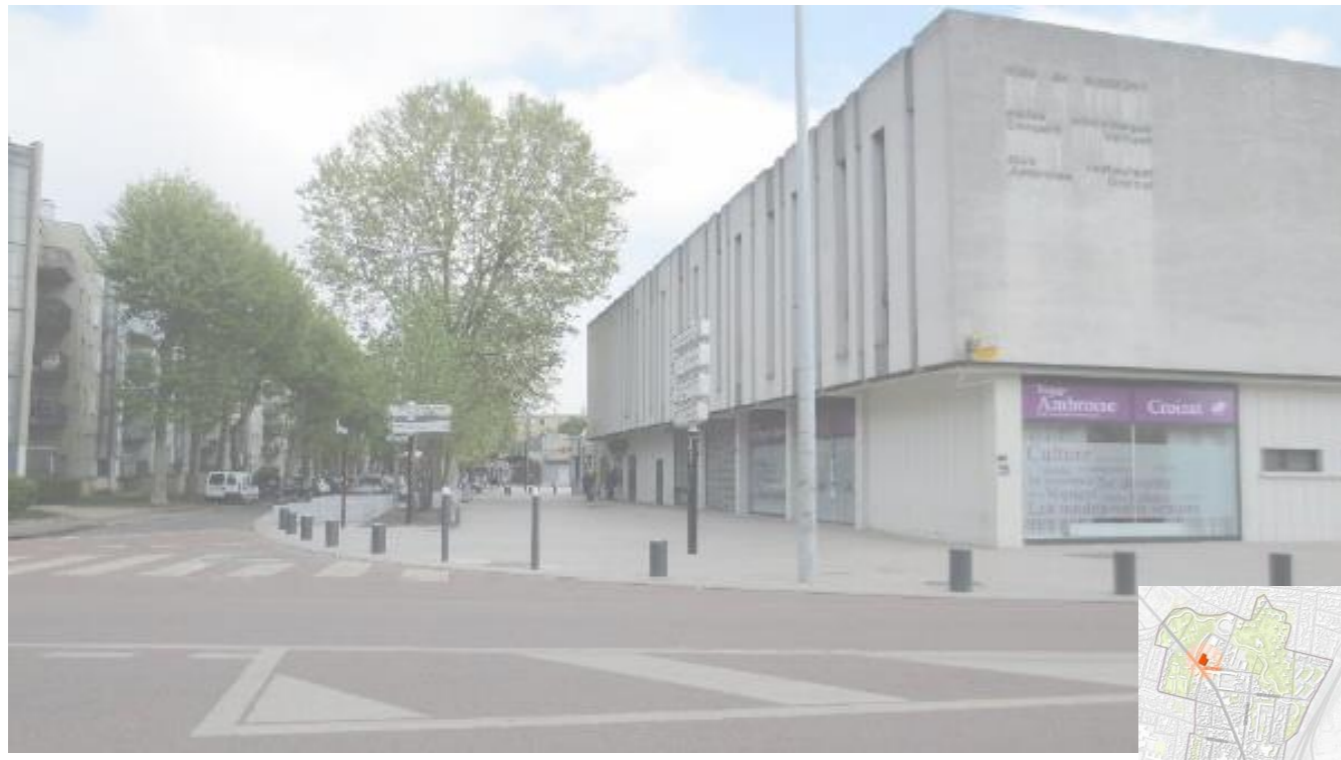
Complexe Edouard Vaillant et sa localisation sur la commune - Source : Etude de préprogrammation des équipements publics du quartier Edouard Vaillant – l'Abreuvier
