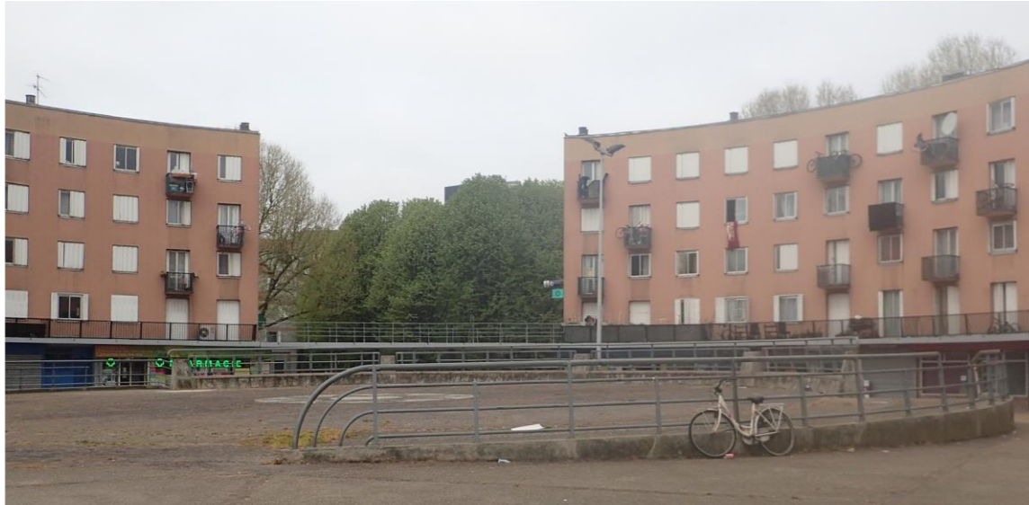
Place des Nations Unies, espace minéralisé créant une rupture dans le paysage - Source : Etude projet urbain du quartier Edouard Vaillant Abreuvoir
