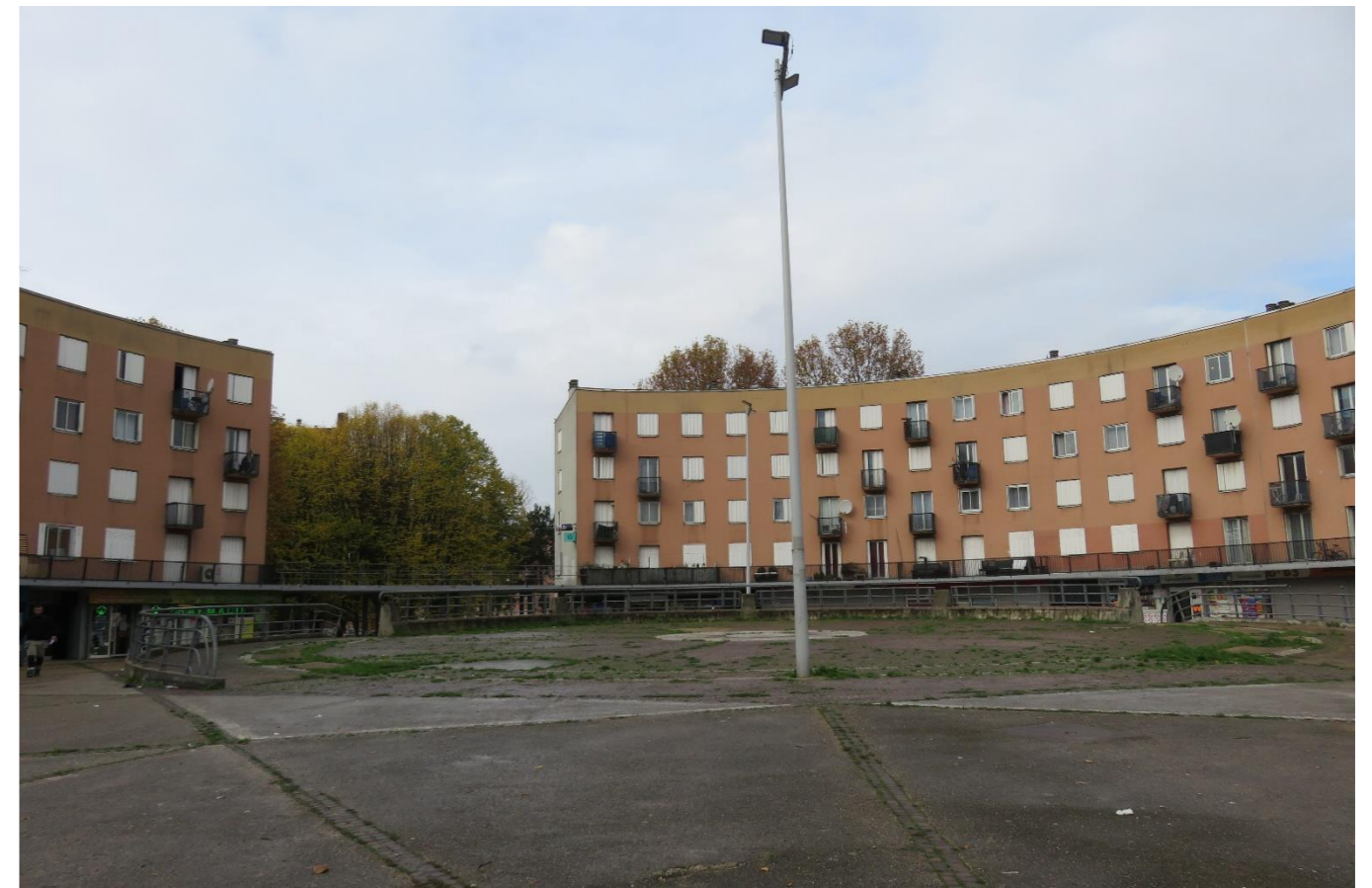
Place des Nations Unies, minérales et totalement inutilisée par les habitants à requalifier pour la revaloriser / Even conseil
